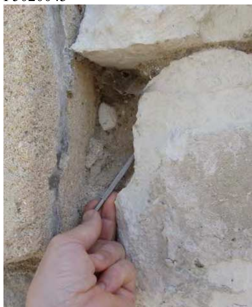
26. ↓ Portail ouest, 6 ème assise du parement à droite, contre les pierres dures : terre mêlée de chaux. P5020043
