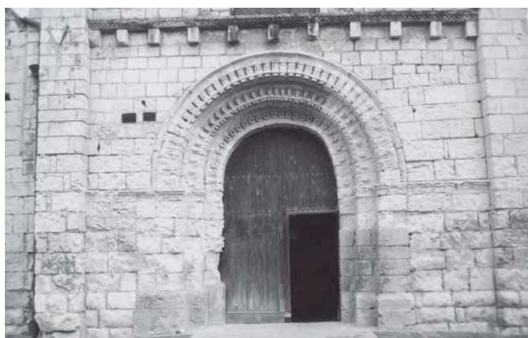
83. ←Photo Charreau 1987. la comparaison avec l'état actuel montre que les dommages dus aux sels ont encore évolués depuis : déplaçage sous la corniche et perte de relief dans la voussure (exemple : on devine encore ici le bouton sur le 2 ème claveau en bas à droite du premier rouleau, bouton totalement disparu aujourd'hui).
