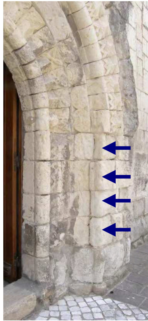
20. ← Portail nord, ébrasement est : les blocs désignés par des flèches, 4 ème et 5 ème assises dans le prolongement du bandeau, sont très peu épais (on distingue le joint vertical au creux du bandeau). P5240034
