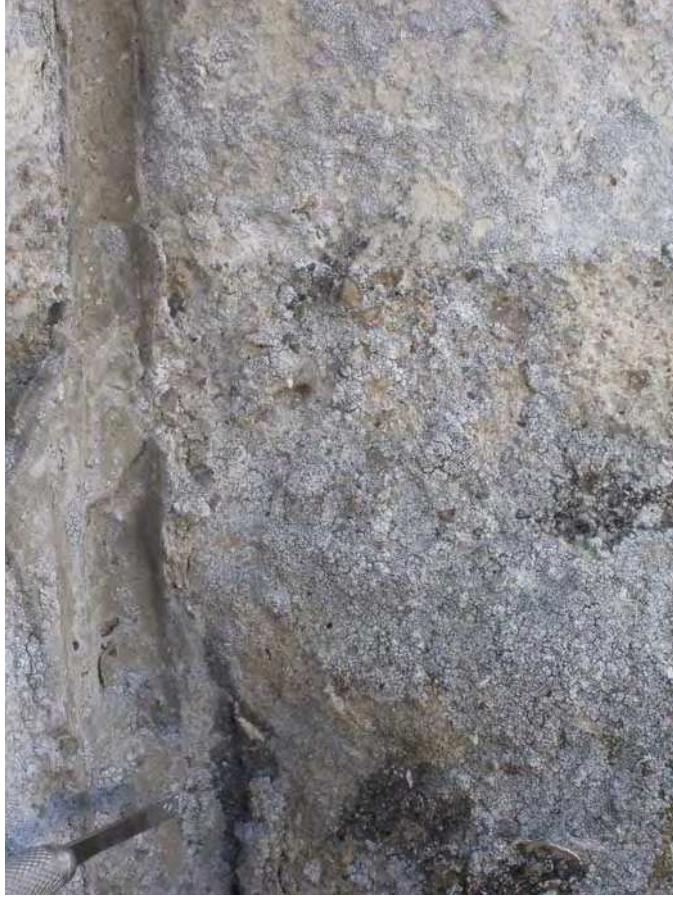
62. ← Coin supérieur gauche des blocs de pierre dure en bas à gauche du portail ouest: couverture de lichens. P4200049
