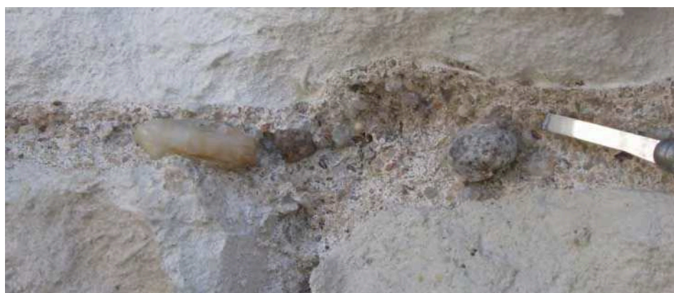
26. ↓ Portail ouest, 6 ème assise du parement à droite, contre les pierres dures : terre mêlée de chaux. P5020043
