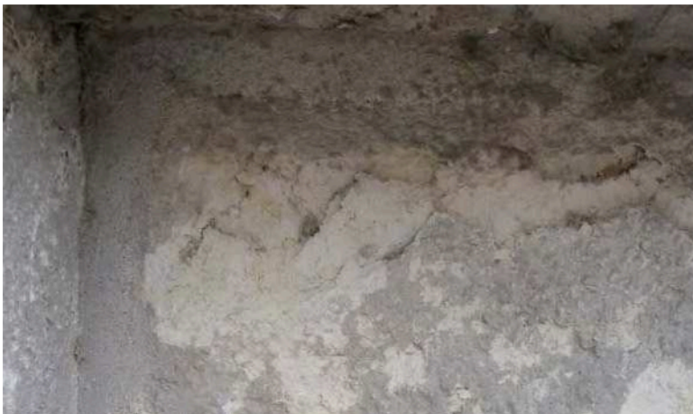
52. ← Juste sous la grande corniche au-dessus du portail ouest, contre le 9 ème modillon (partiellement visible à gauche sur la photo, largeur du champ 20 cm environ) : tuffeau désagrégé, boursoufflé par l'action des sels solubles, sulfates en particulier : voir ERMD2 figure 60 page 22. P4280272
