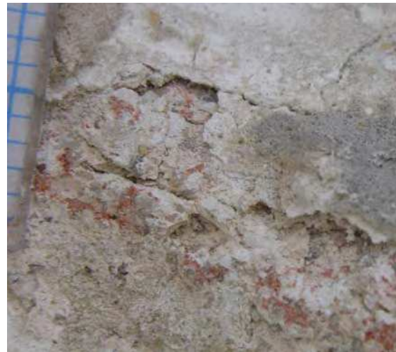
30. ↓ Grossi cinq fois environ : deux badigeons blancs couvrent des restes d'ocre rouge sur une couche blanche mince, sur un mortier de sable et chaux. P5150016
