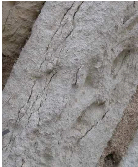
49. ← Détail gros cinq fois environ: très nombreuses fissures plus ou moins parallèles produisant un feuillete dans le tuffeau P4200105
