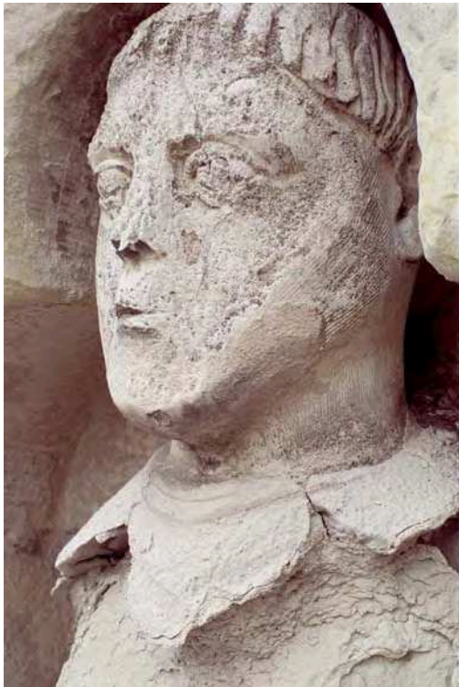
87. ↓ Détail de la sculpture au sud de la façade : une tête refaite en plâtre contamine depuis des années le tuffeau autour, profondément désagrégé par l'action du gypse. Le plâtre est probablement présent ailleurs sur la façade. Etat en novembre 2000. 2000-11-13-0024
