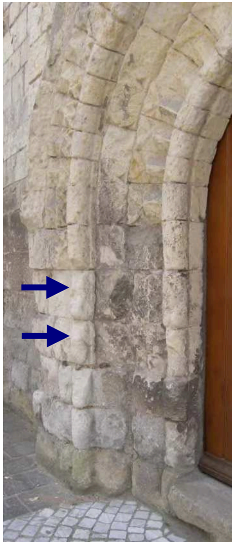
20. ← Portail nord, ébrasement est : les blocs désignés par des flèches, 4 ème et 5 ème assises dans le prolongement du bandeau, sont très peu épais (on distingue le joint vertical au creux du bandeau). P5240034
