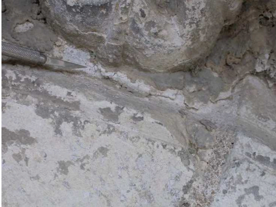
32. ← Portail ouest, voussure, 1er rouleau, côté sud, 9ème claveau, grandeur nature: restes de badigeons et poussières, détail figure 33. P4280294
