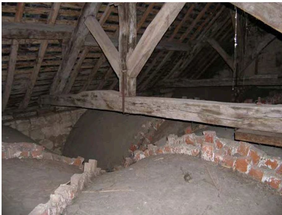
10. ↓ Partie sud de la voûte de la nef, juste derrière la façade; photo prise du haut vers le bas, le sommet de la voûte est en haut sur la photo, l'ouest et le pignon sont à gauche, le mur sud est en bas, le toit en bas également; on remarque la lézarde montant du mur sud dans la voûte de brique et plâtre. P5300025
