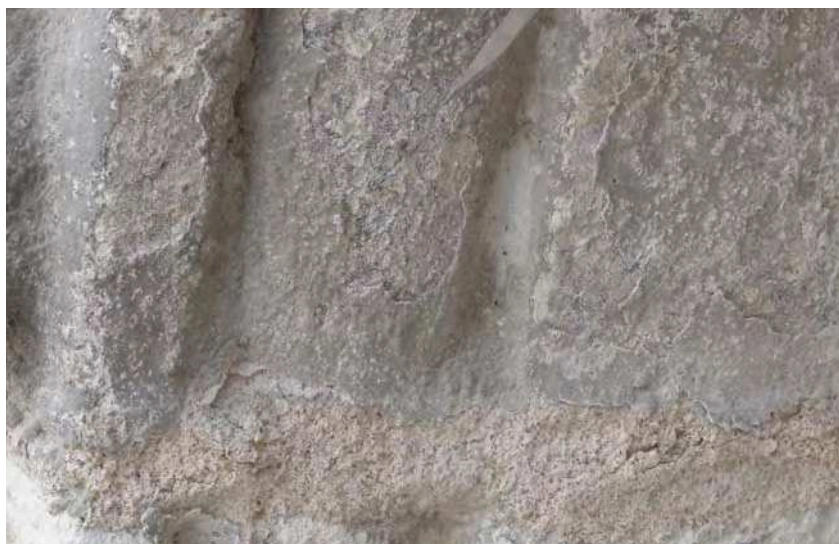
31. ← Grandeur nature, détail de la figure 28, bas du 7 ème claveau, intrados : des sondages antérieurs à cette étude découvrent une couche sombre très lacunaire, à préciser par un complément d'observation sous microscope binoculaire. P5150016
