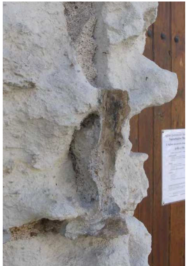
43. ↓ Portail nord, voussure, 1 er rouleau, côté est, 1 er claveau : restes de bouchages et de rejointoiement au plâtre. P5240026
