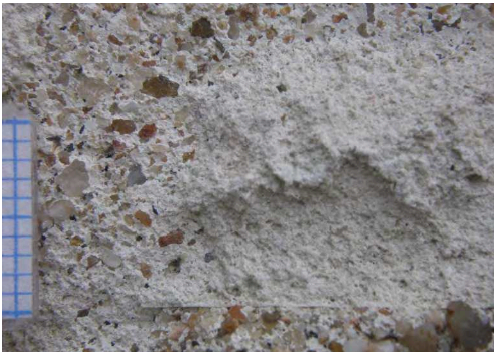
40. ← Détail grossi cinq fois environ, sondage sur le bas du ragréage de la figure 39 : le mortier imitant le tuffeau, à droite sur la photo, est en fait posé sur le même mortier qui dessine les faux joints (un faux joint ici en bas). P4200098.
