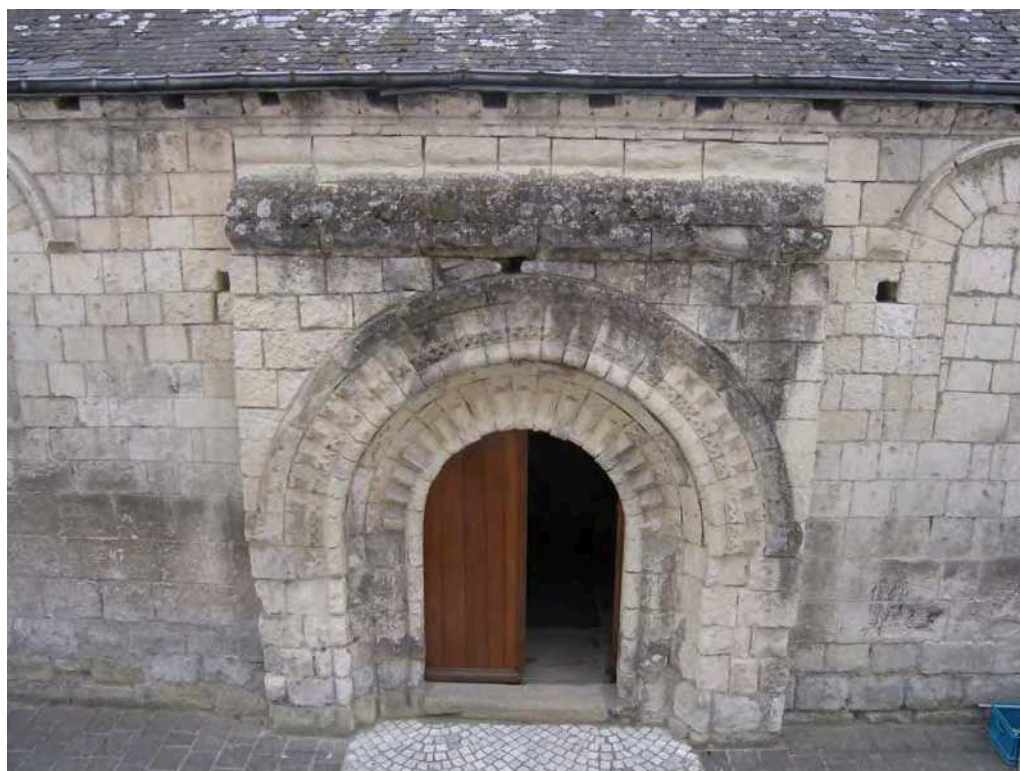
68. ← Vue plongeante sur le portail ouest : lichens et mousses sur le talus et la partie supérieure droite du portail. P5240018
