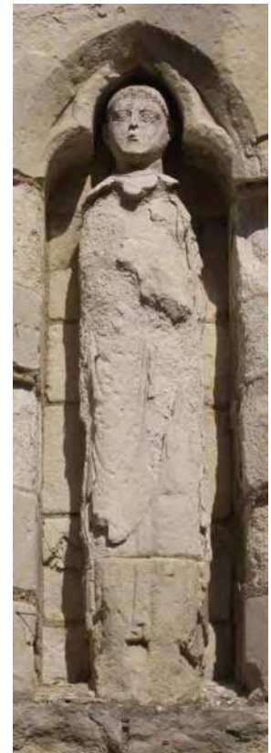
89. ↓ Etat 2006 : déplaquage sur l'arc, perte de fragments de statue côté dextre. P6220010
