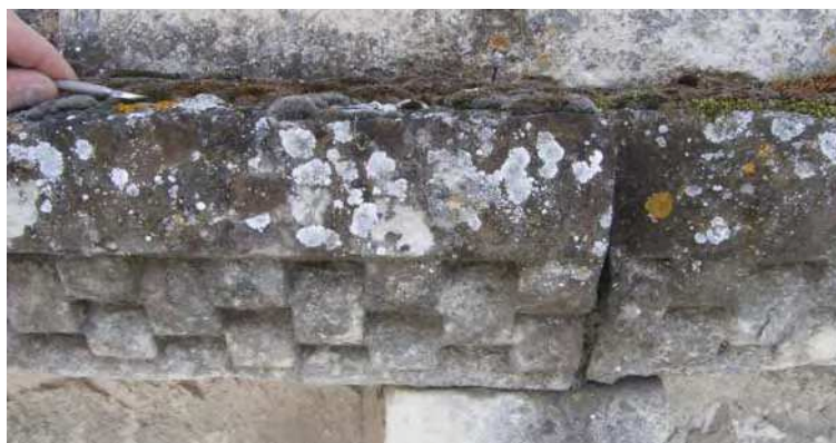
65. ← Grande corniche, au-dessus du 10 ème modillon: mousses sur la partie horizontale, lichens devant. P4280255
