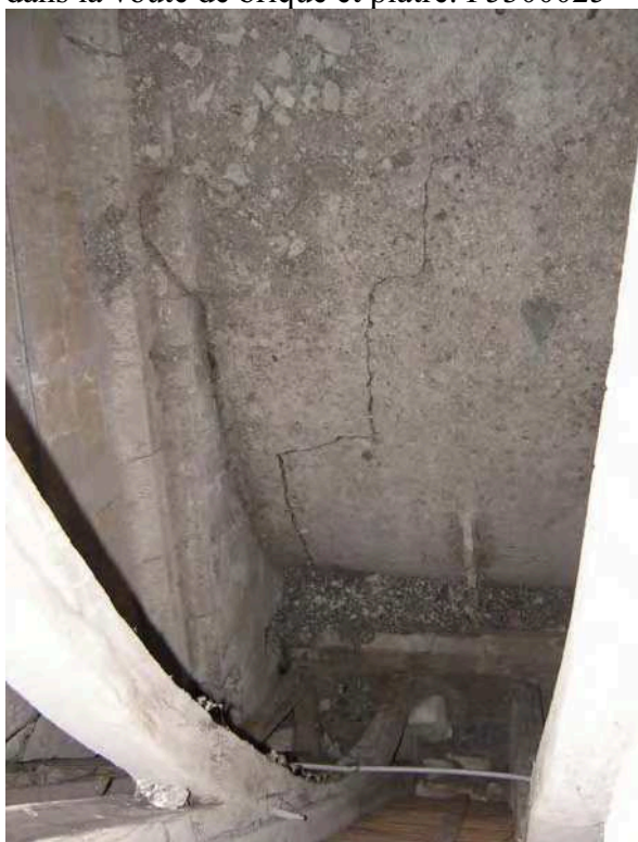
10. ↓ Partie sud de la voûte de la nef, juste derrière la façade; photo prise du haut vers le bas, le sommet de la voûte est en haut sur la photo, l'ouest et le pignon sont à gauche, le mur sud est en bas, le toit en bas également; on remarque la lézarde montant du mur sud dans la voûte de brique et plâtre. P5300025
