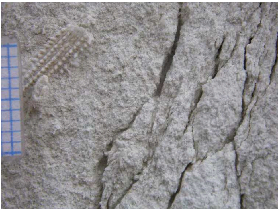
49. ← Détail gros cinq fois environ: très nombreuses fissures plus ou moins parallèles produisant un feuillete dans le tuffeau P4200105
