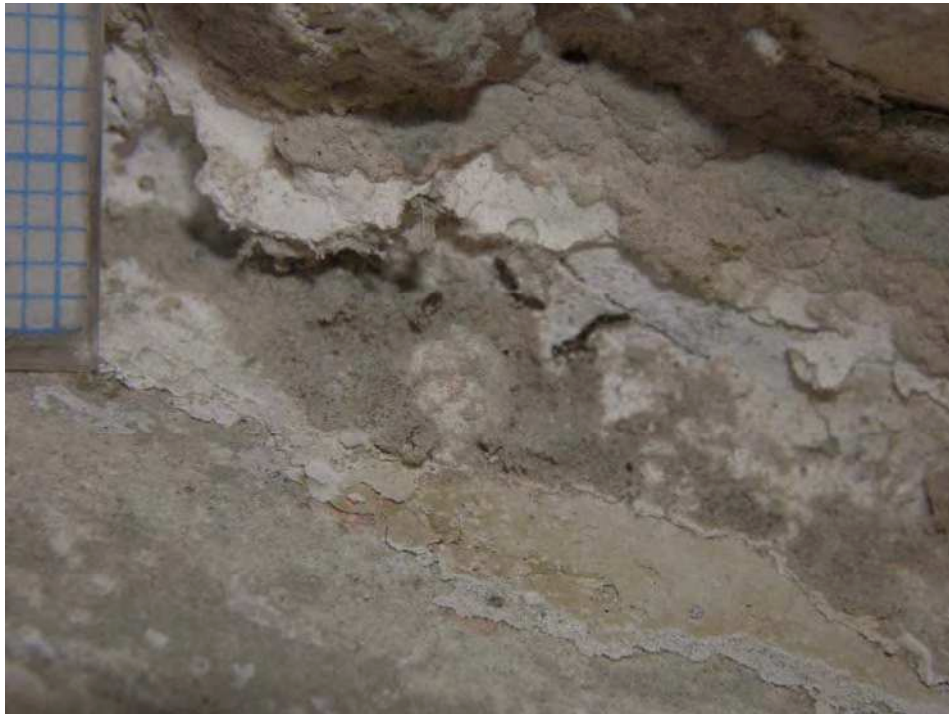
33. ← Grossi cinq fois environ, détail de la figure 32: la poussière recouvre un badigeon blanc épais très irrégulier, sur une nouvelle couche de poussière épaisse, sur un badigeon plus mince, sur un encrassement ocre, sur un
