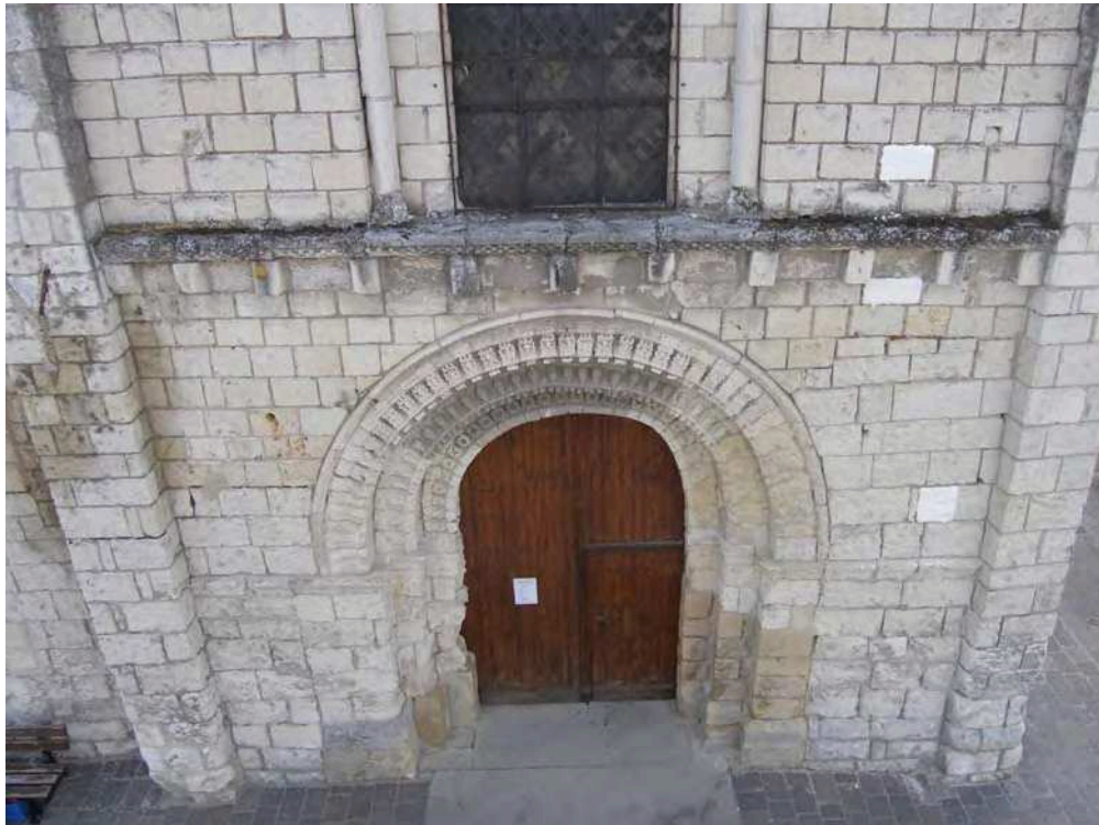
64. ← Vue plongeante sur le portail ouest : lichens et mousses sur la corniche. (Rectangles blancs à droite : tests de dessalement par compresses) P5020001
