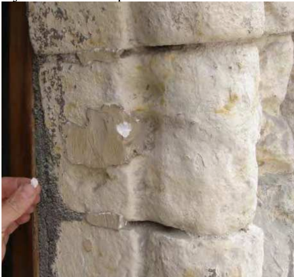
43. ↓ Portail nord, voussure, 1 er rouleau, côté est, 1 er claveau : restes de bouchages et de rejointoiement au plâtre. P5240026
