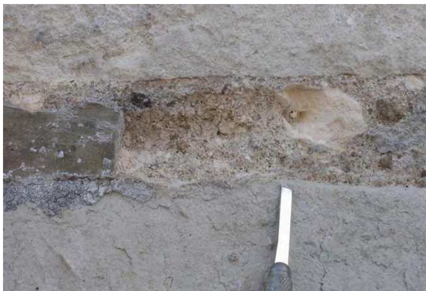
24. ← Façade ouest, joint au-dessus de la 3 ème assise à gauche du portail, 2 ème bloc en partant de la droite. Mortier de pose supposé d'origine, grandeur nature: sable et chaux, cette dernière parfois visible en grosses inclusions blanc-jaunâtre. A gauche, rejointoiement au ciment. P4200047
